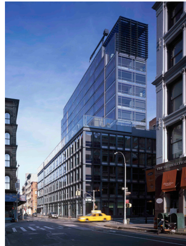
40 Mercer New York, NY Jean Nouvel Ateliers
