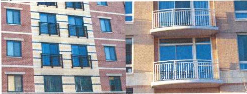
1200 EW Highway – 3 door balconies
